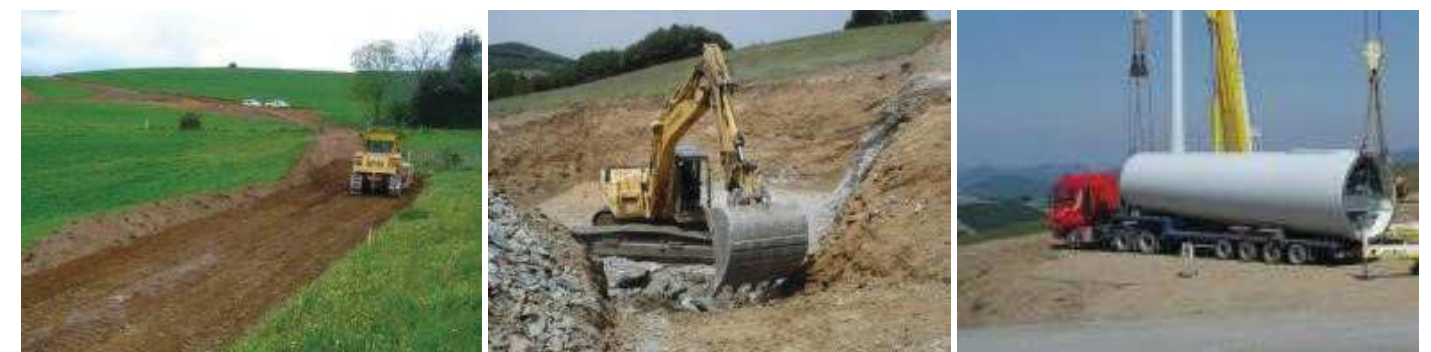
Photographie 126 : Illustration d'un chantier éolien
